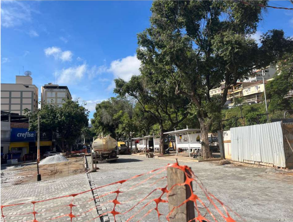
Foto 06: Pontos de Ônibus existentes ao lado do Museu Ferroviário
