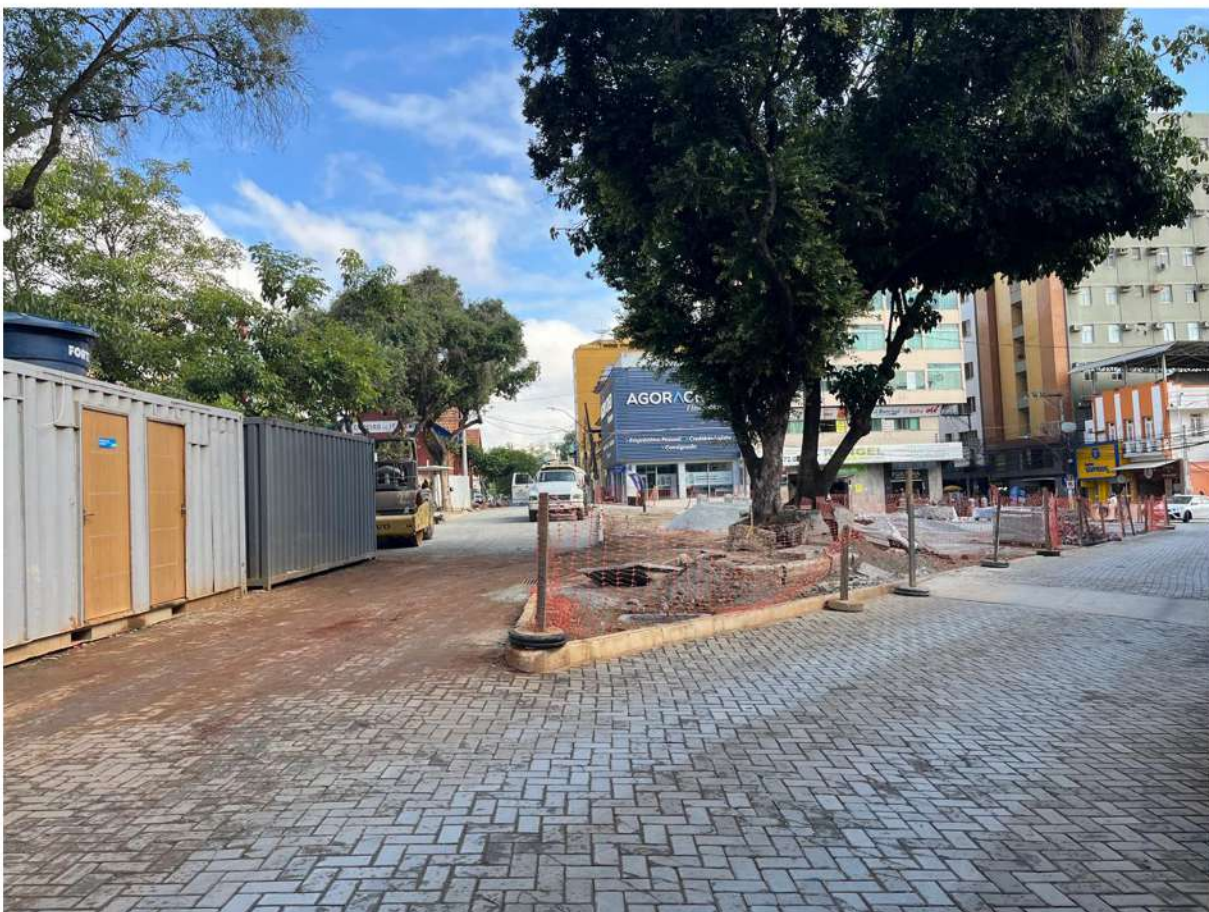
Foto 03: Vista de esquina do terreno
