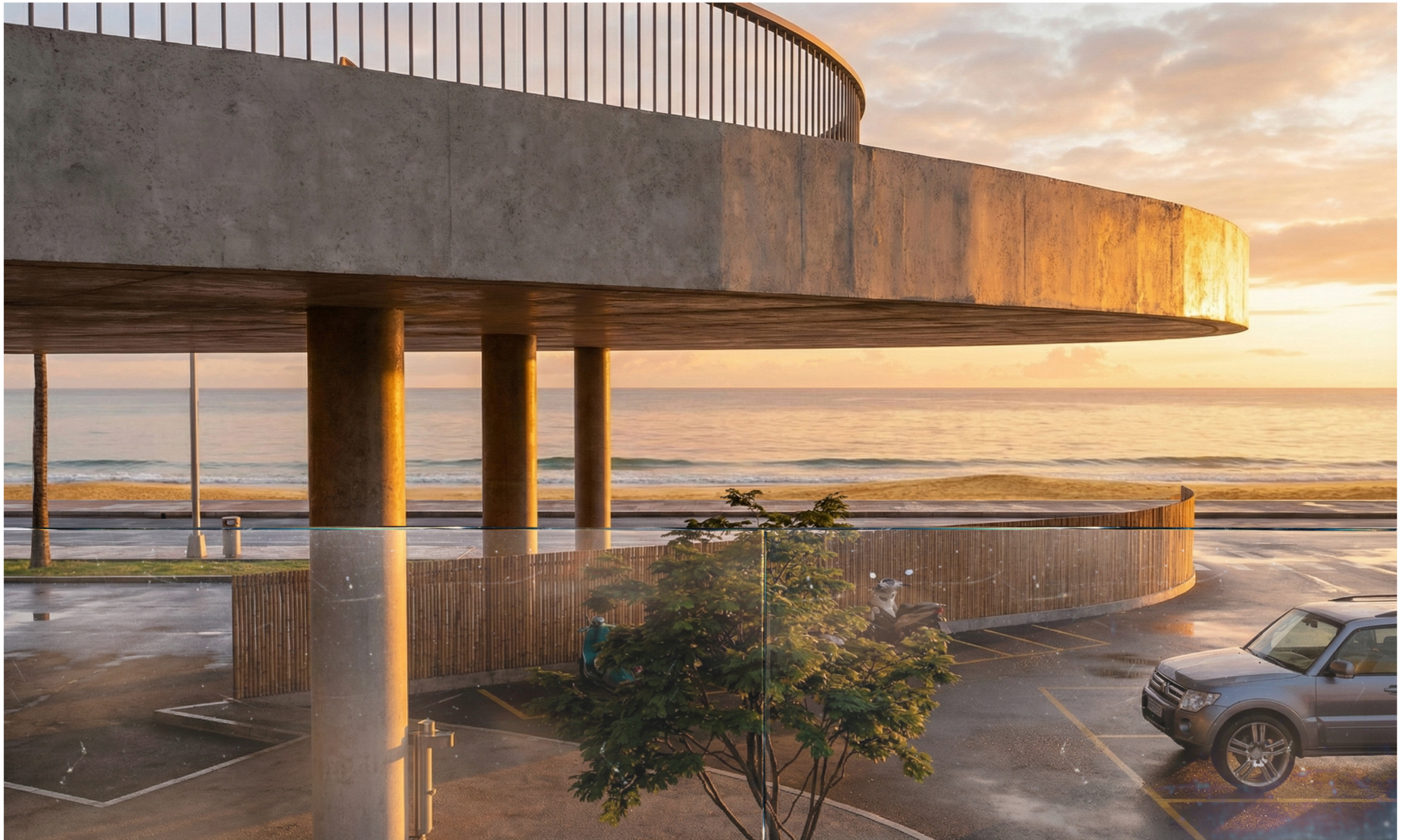
Detalhe da cobertura
