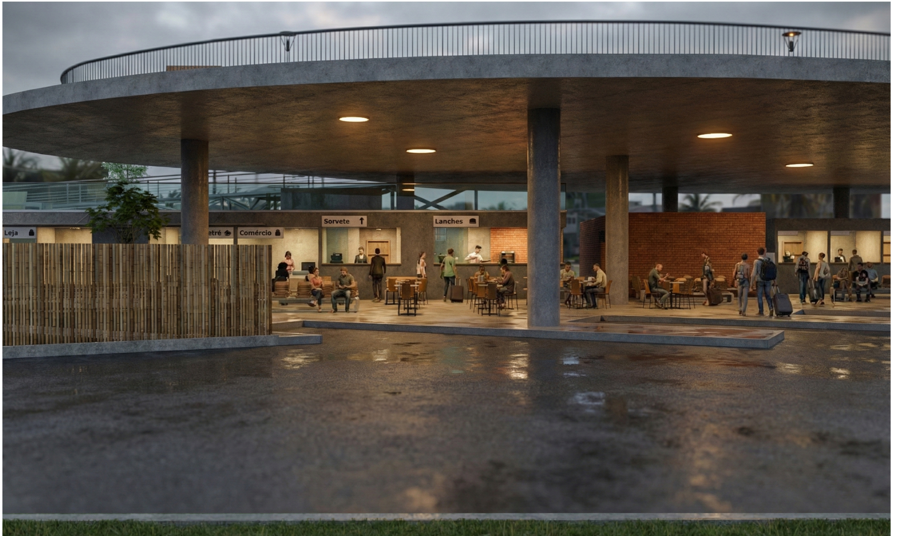
Terminal de embarque, vista do estacionamento
